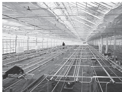
写真 2-24 建設中の水耕栽培ハウス
