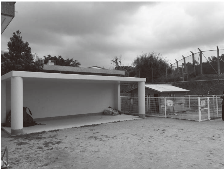
【写真1】米軍機の落下事故などに備えて作られた，普天間第2小学校にある「シェルター」。2019年2月，仲村未央沖縄県議，岸本喬沖縄平和運動センター事務局次長の案内で飯島撮影。
