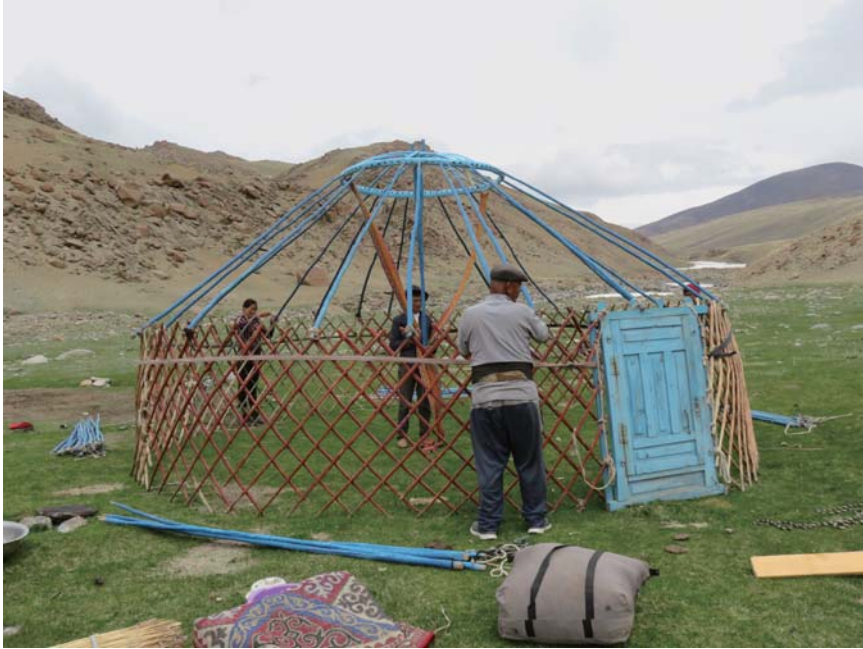
図5 住居を組み立てているところ
